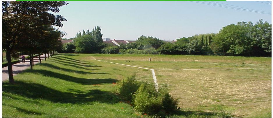
Bassin de stockage des eaux pluviales à Chevilly La Rue (94)
