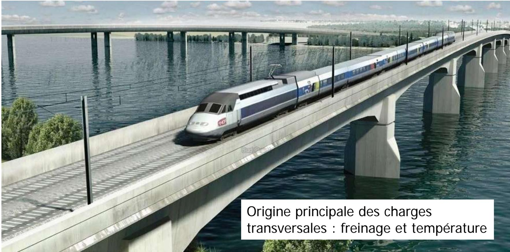
Origine principale des charges transversales : freinage et température
